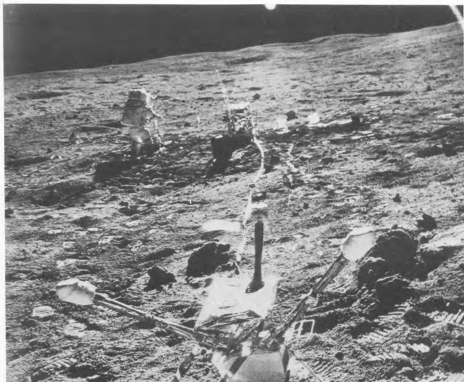
▲アポロ12号の飛行士が科学実験装置をセットしている場面。
