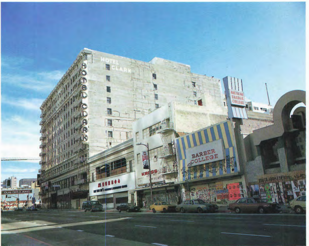
▶ロサンジェルス市のヒル・ストリートに残るホテル・クラーク。内部は解体されており、営業されていない。撮影/久保田八郎
