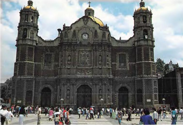
◀グアダルーベ大寺院。地盤沈下のため傾いている。
